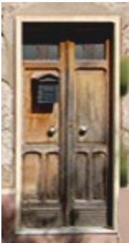
Variante A3 - schema trilitico di base con sopraluce incorporato nelle ante
