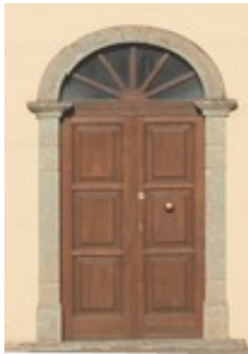
Variante A4 - schema trilitico di base con vetrate Porta di accesso alla corte interna
