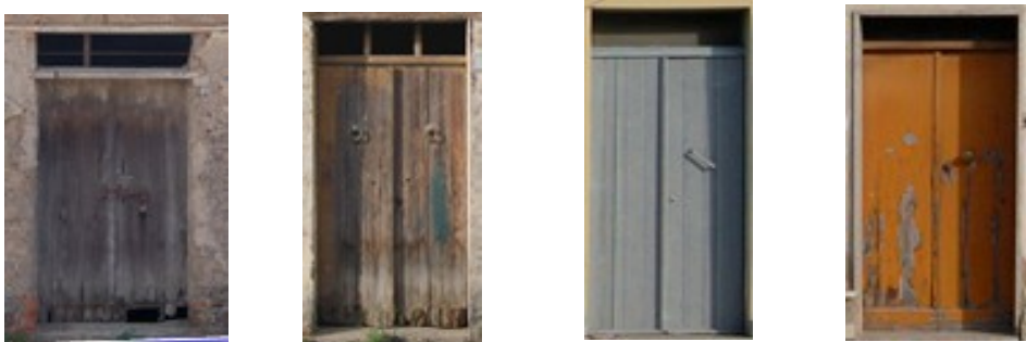
Variante A2 - schema trilitico di base con doppio architrave con funzioni di sopraluce
